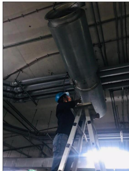
Pic no 23- Jet flow fan testing
